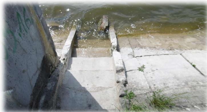
Jaz upustowy – stan budowy, umocnienia górnego i dolnego stanowiska, schody skarpowe
