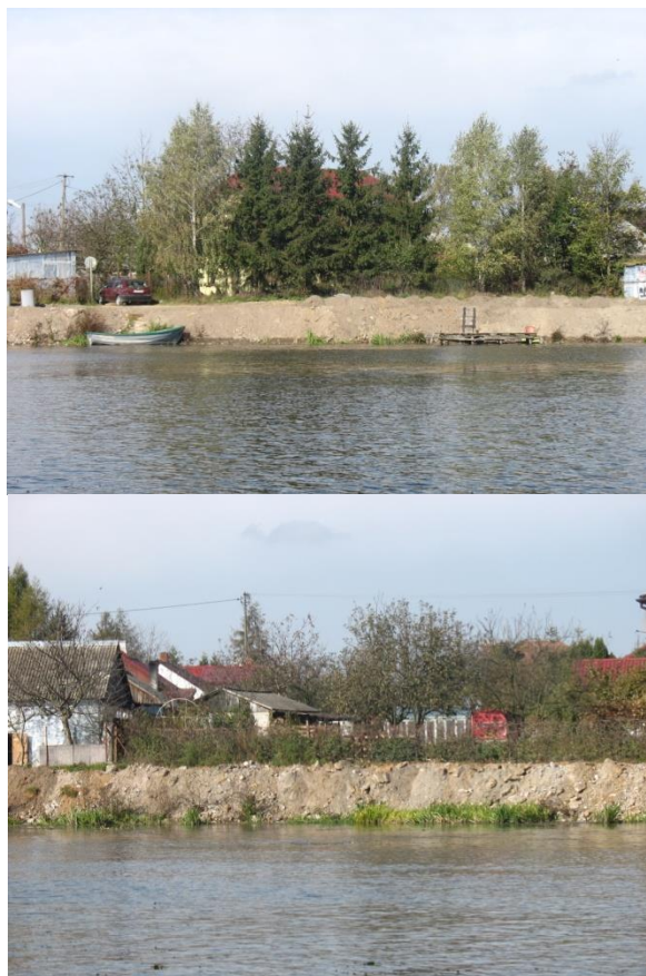
Fot. 2. Południowy i południowo-zachodni brzeg po pracach budowlanych (październik 2010)
