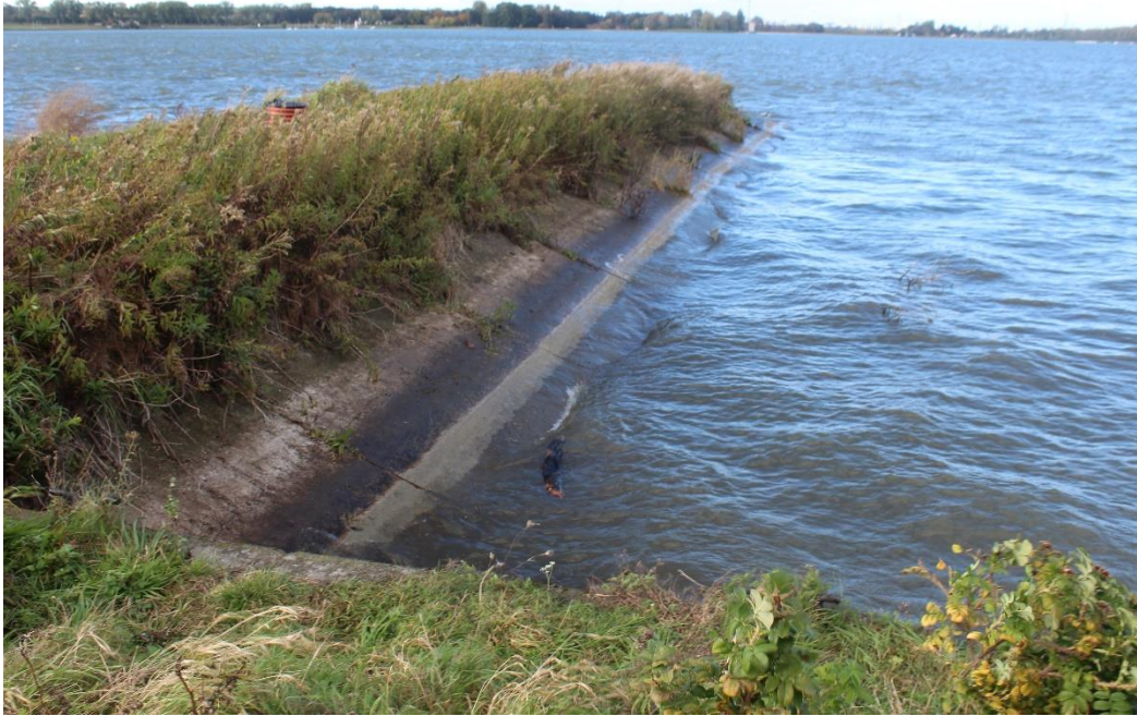
Fot. 41. Widok ostrogi – ubezpieczenie skarpy płytami betonowymi.
