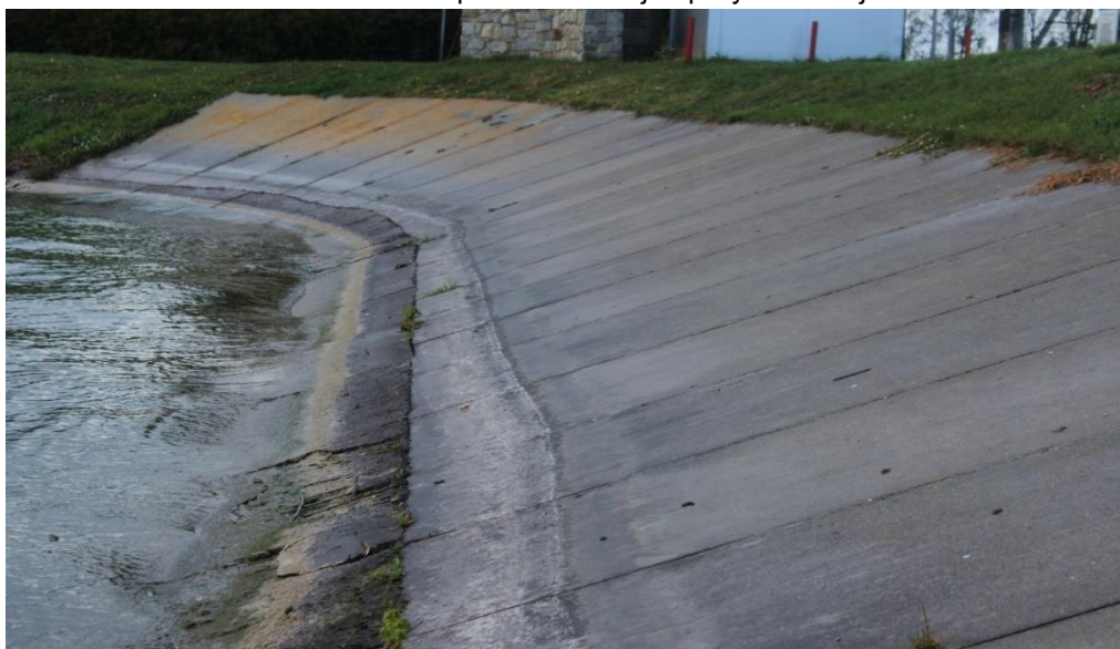
Fot. 4. Widok ubezpieczeń z płyt betonowych skarpy odwodnej lewobrzeżnej zapory czołowej.
