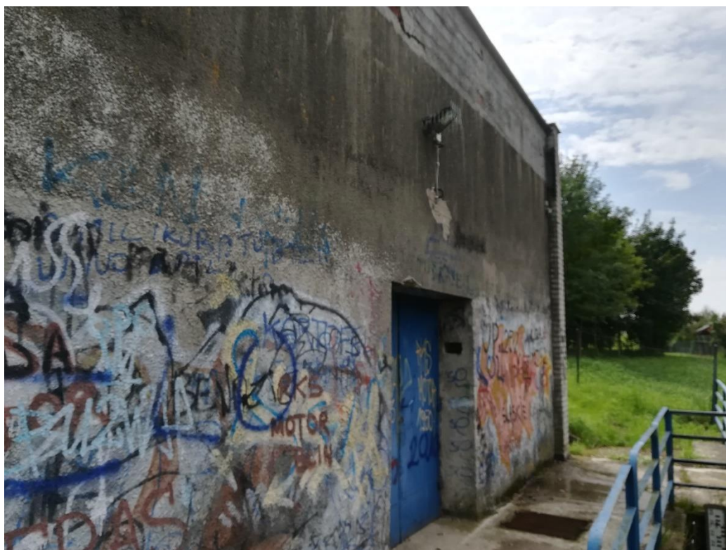
Fot. 83. Budynek pompowni P-2 – lewy brzeg Zalewu.
