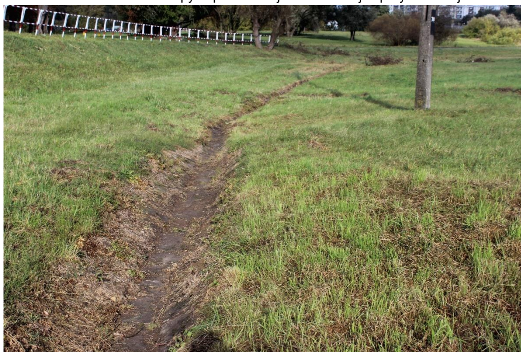
Fot. 12. Widok koryt odwodnieniowych powierzchniowych zapory lewobrzeżnej.
