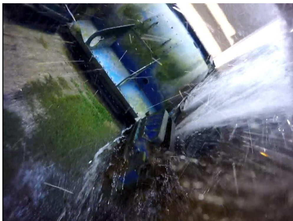
Zdjęcie nr 34. Kłapa jazu (prawa) widok od strony wody dolnej.
