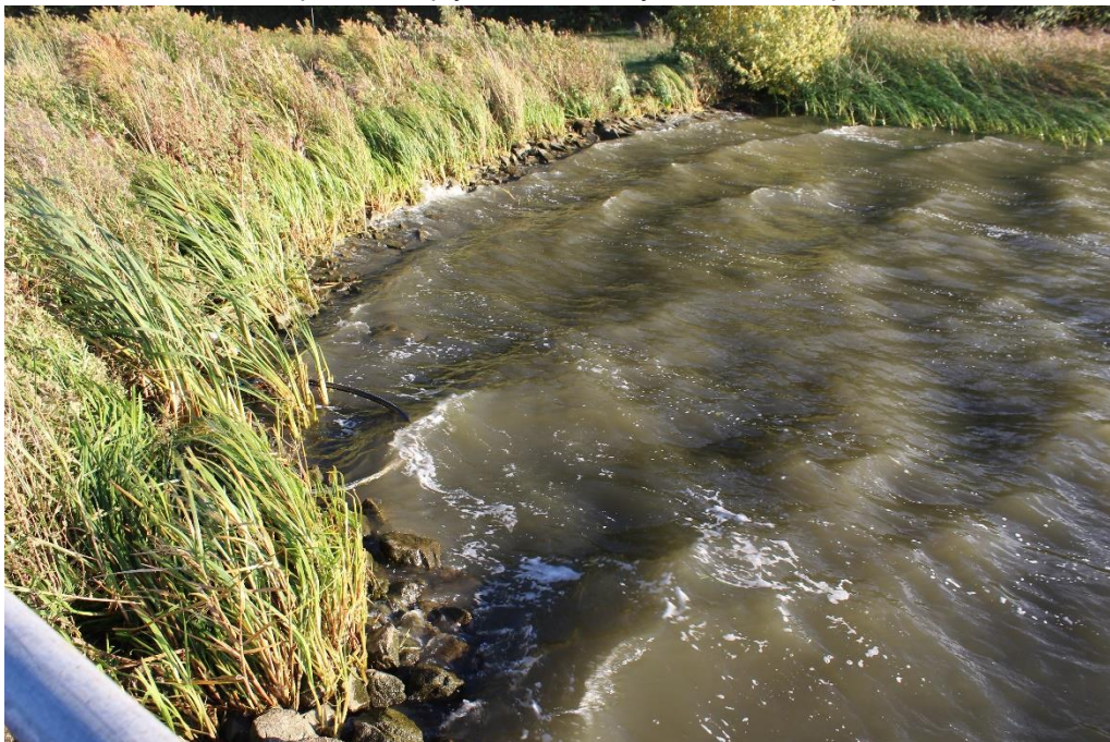
Fot. 44. Początek ubezpieczenia brzegu narzutem kamiennym za pomostem nr 3.
