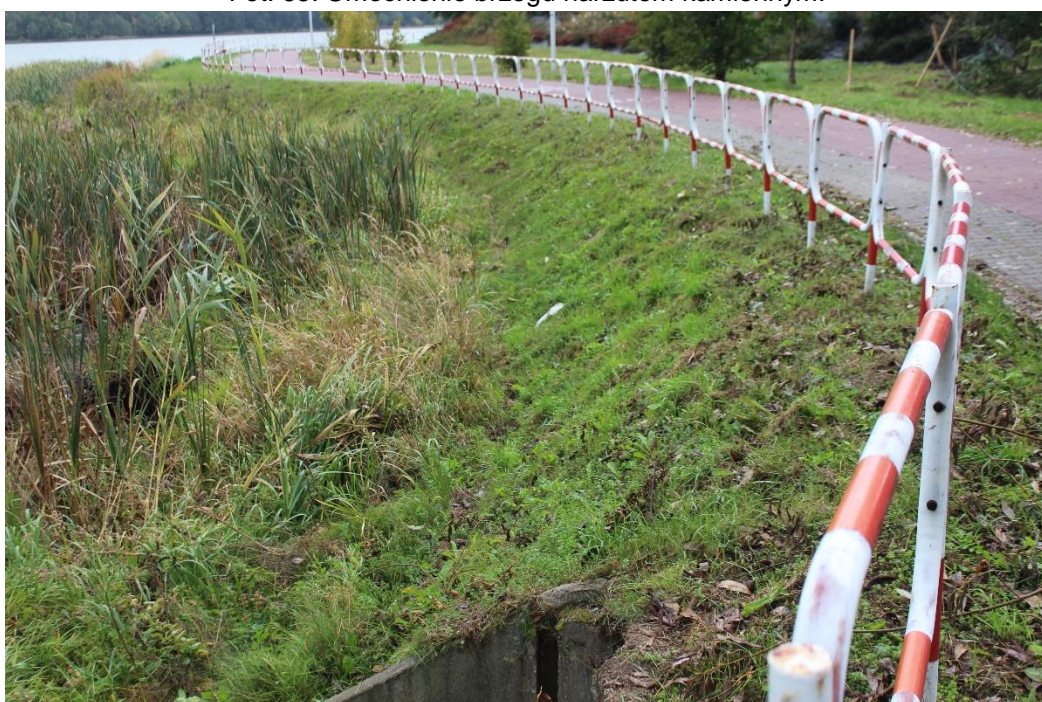
Fot. 66. Widok skarpy odwodnej, poniżej umocnienie narzutem kamiennym.
