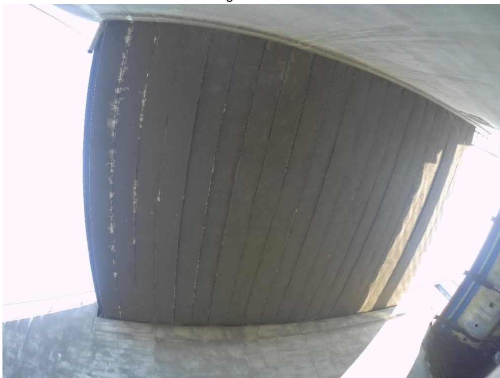
Fot. 26. Widok spodu konstrukcji mostu nad jazem.
