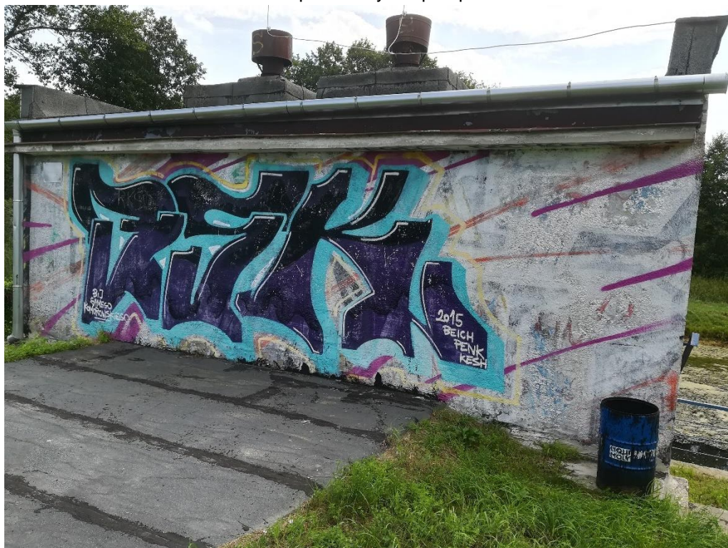
Fot. 82. Budynek pompowni P-1.
