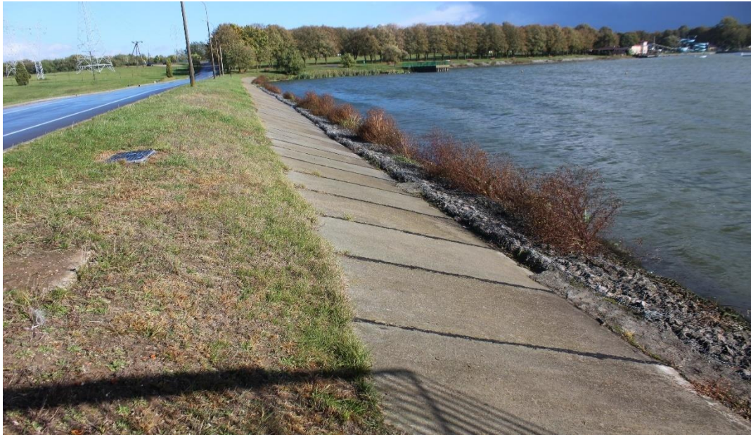
Fot. 5. Widok płyt betonowych i materacy gabionowych – skarpa odwodna prawobrzeżnej zapory.
