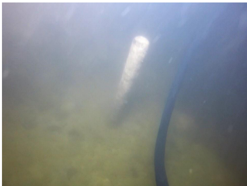
Zdjęcie nr 36. Wystający, z płyty poszuru, pręt.
