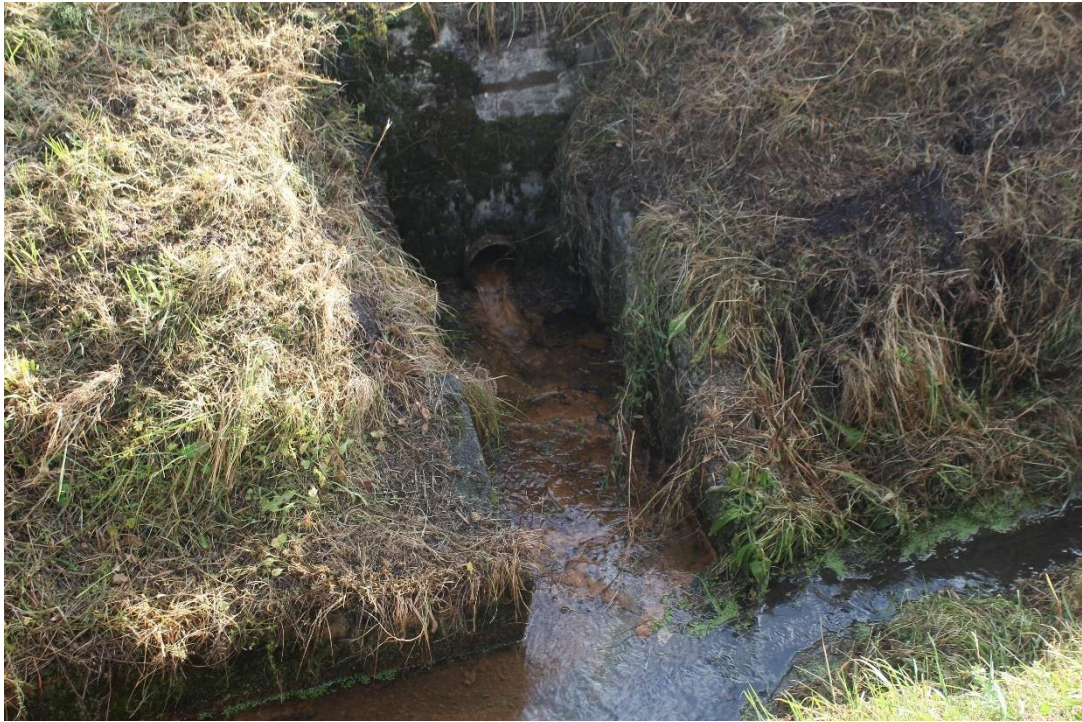
Fot. 13. Wylot drenażu w lewobrzeżnej zaporze.
