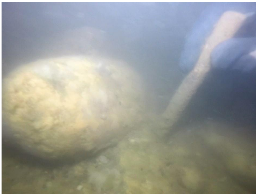
Zdjęcie nr 35. Wystający, z płyty poszuru, pręt.
