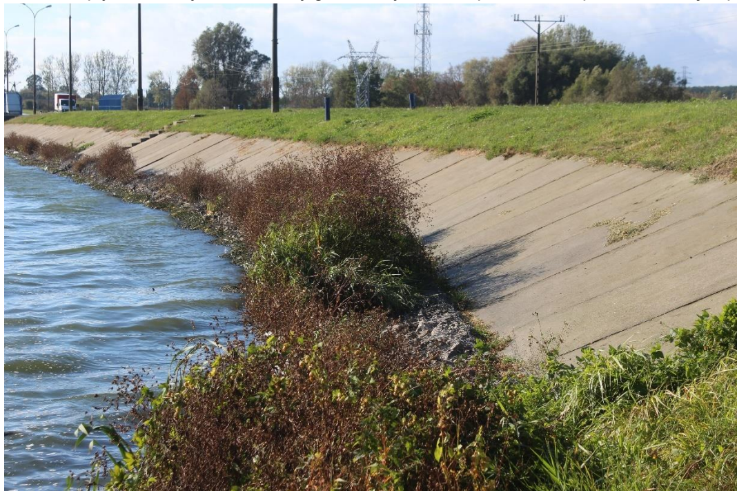
Fot. 6. Widok płyt betonowych i materacy gabionowych – skarpa odwodna prawobrzeżnej zapory.
