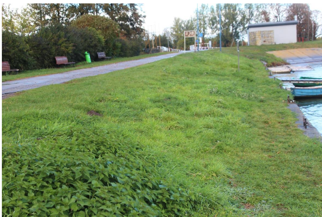
Fot. 54. Początek umocnienia brzegu lewego ścianką szczelną zwieńczoną oczepek żelbetowym przy zaporze czołowej.
