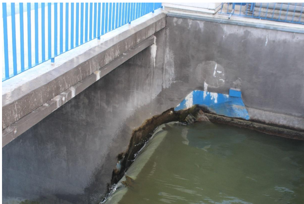
Fot. 21. Filar środkowy - widok powierzchni betonowych w prawym przęśle jazu.
