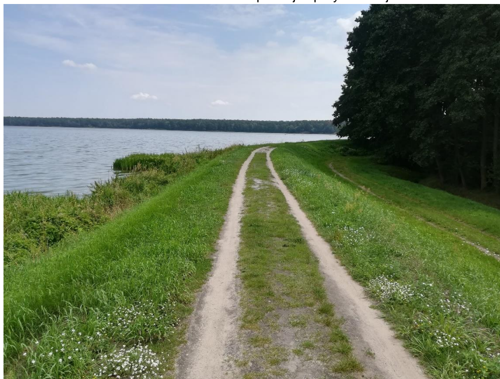
Fot. 50. Widok prawej zapory bocznej przed rozpoczęciem prac.
