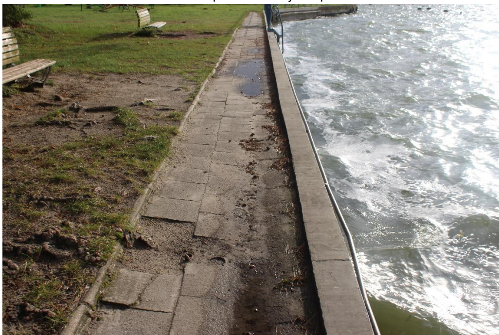
Fot. 36. Chodnik wzdłuż nabrzeża pionowego.
