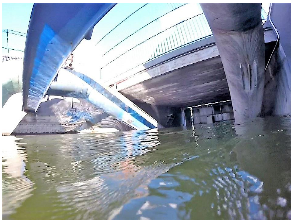
Zdjęcie nr 15. Widok ogólny, drugie przęsło jazu.
