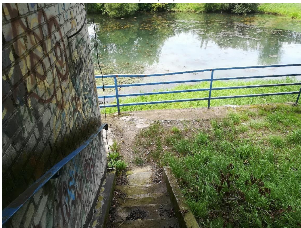
Fot. 86. Budynek pompowni P-2 o raz widok na zbiornik retencyjny.
