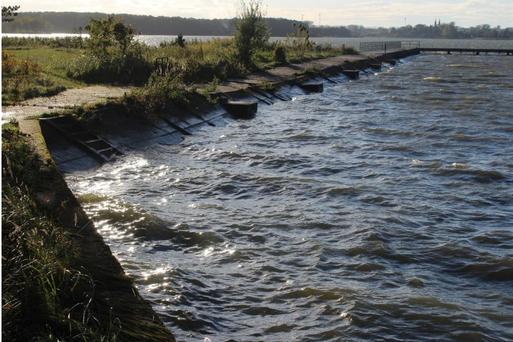
Fot. 43. Ubezpieczenie płytami betonowymi. Widok na pomost nr 3.
