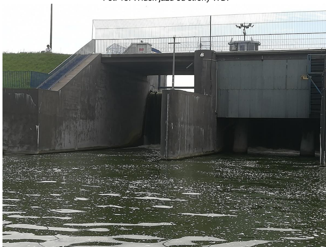
Fot. 16. Widok jazu od strony WD.
