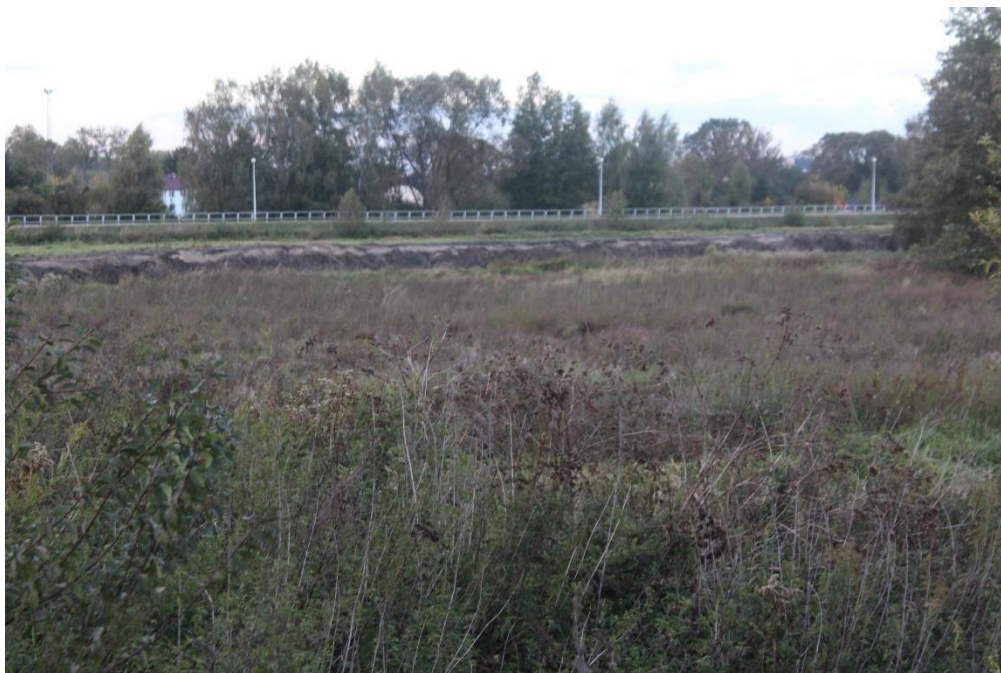
Fot. 49. Widok remontu prawej zapory bocznej.
