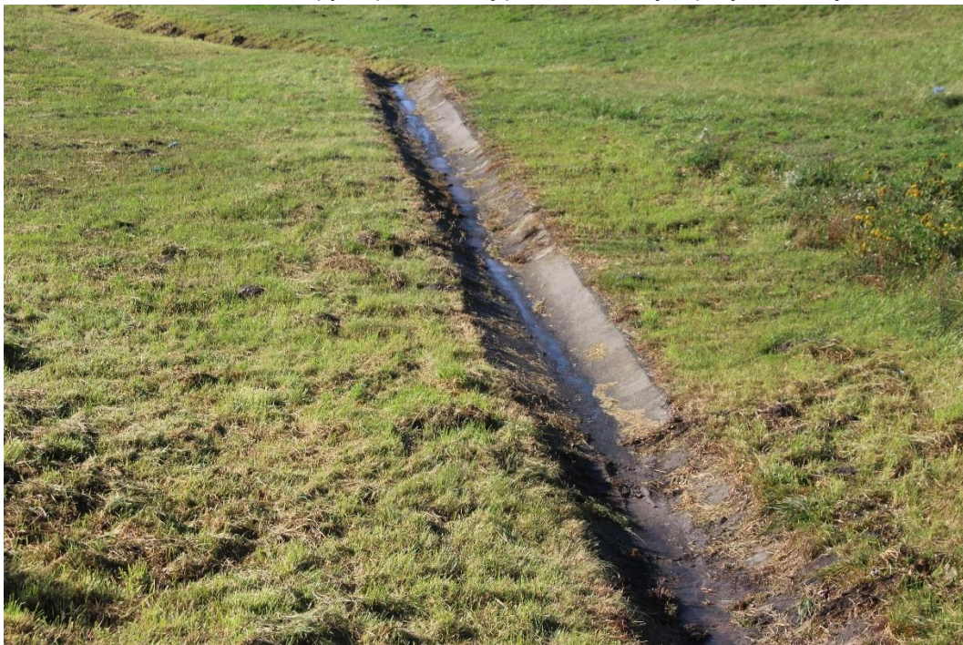
Fot. 10. Widok koryt odwodnieniowych powierzchniowych zapory prawobrzeżnej.
