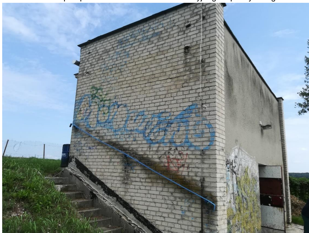
Fot. 80. Budynek pompowni P-1.
