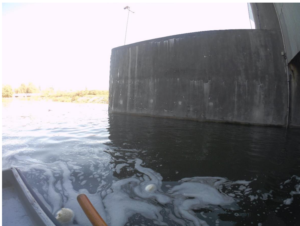
Fot. 23. Widok powierzchni betonowych filara środkowego jazu od WD.
