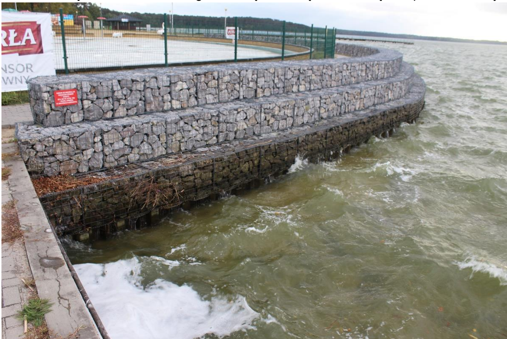
Fot. 34. Umocnienie brzegu ścianką szczelną i koszami gabionowymi – rejon kompleksu basenów „Słoneczny Wrotków”
