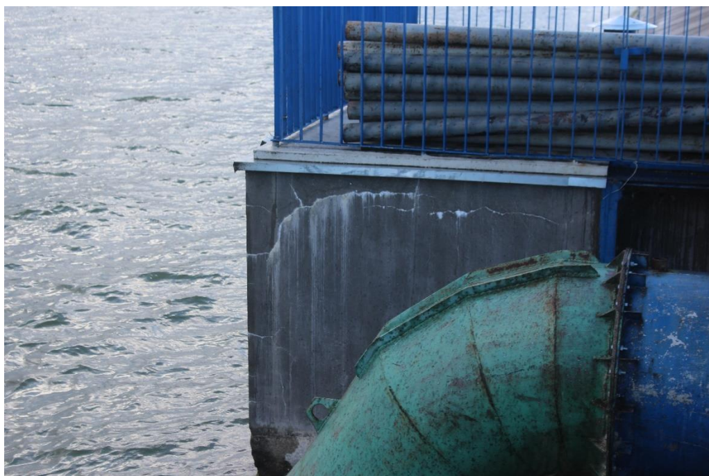
Fot. 19. Widok powierzchni betonowych lewego przyczółka jazu od WG.
