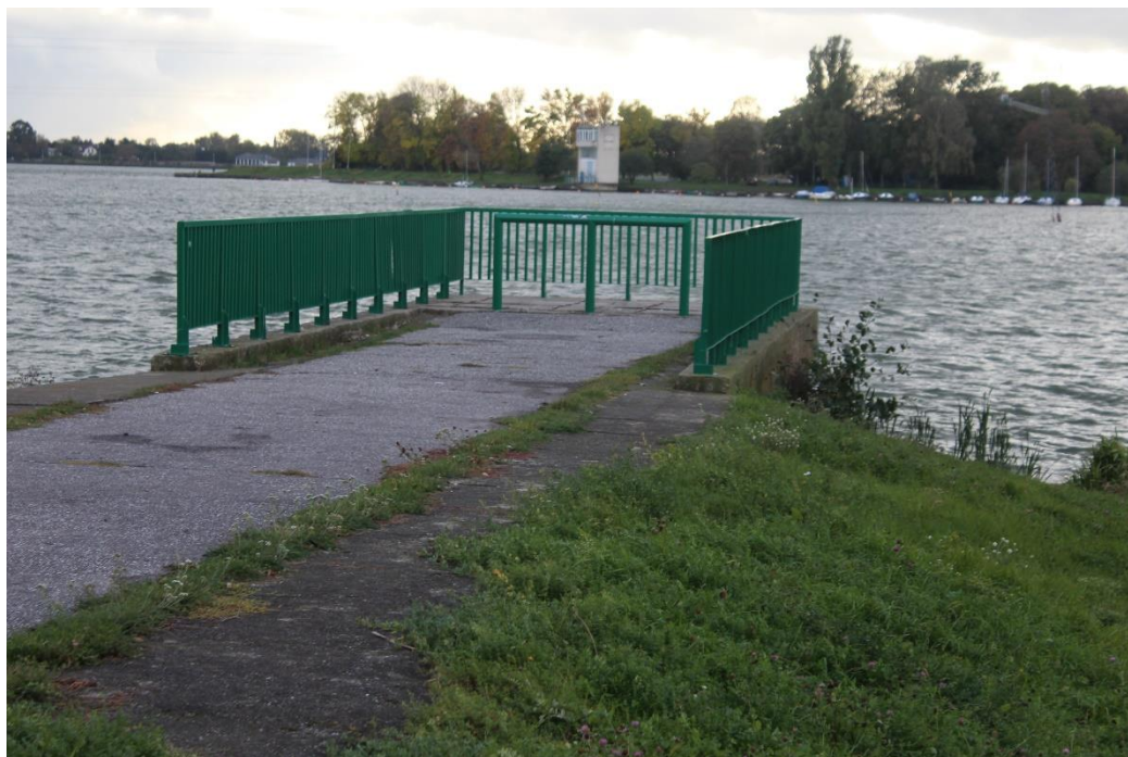
Fot. 31. Widok ujęcia wody powierzchniowej – PGE.
