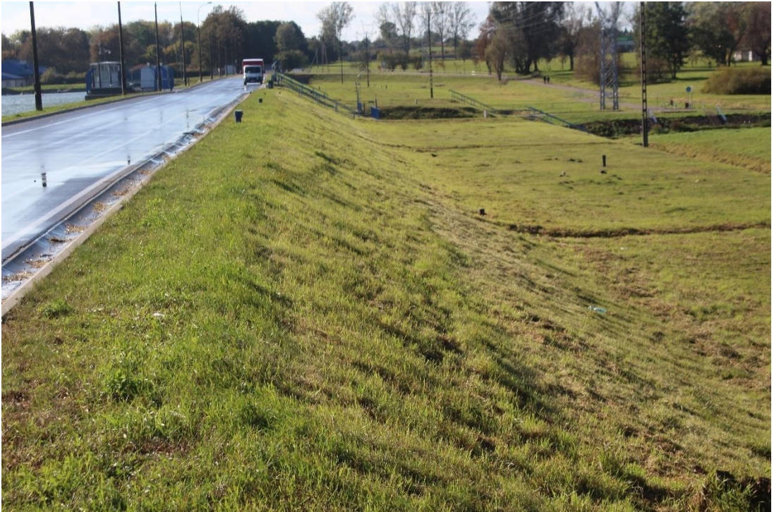
Fot. 8. Widok skarpy odpowietrznej prawobrzeżnej zapory czołowej.
