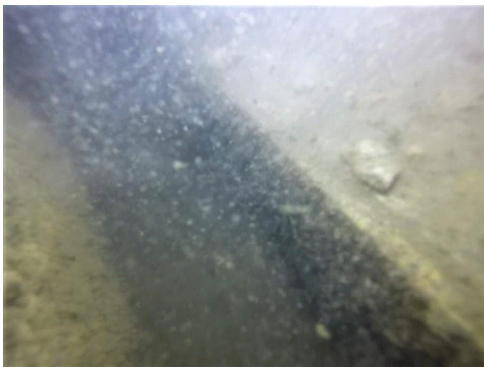
Zdjęcie nr 3 Krawędź płyty ponuru (po prawej stronie) i worek (po lewej).
