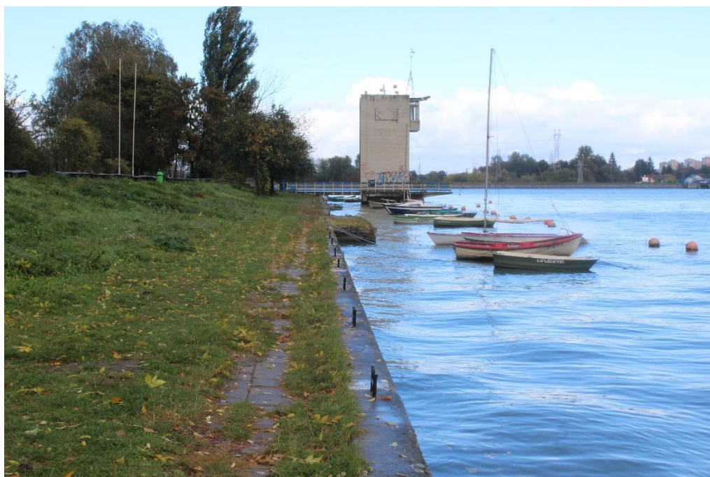
Fot. 59. Widok nabrzeża pionowego, w tle widoczna wieża sędziowska.
