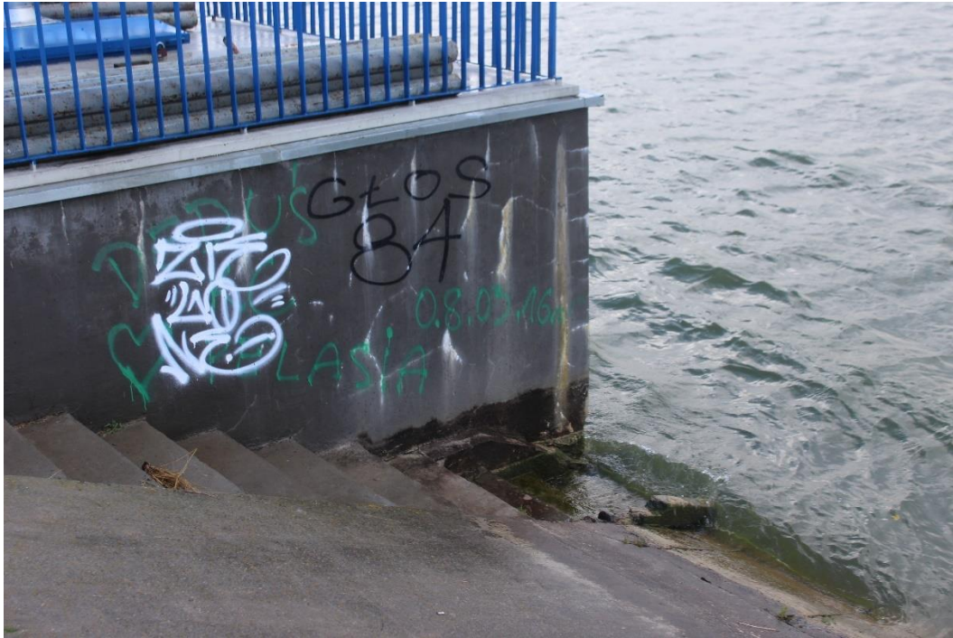
Fot. 17. Widok powierzchni betonowych lewego przyczółka jazu od WG.
