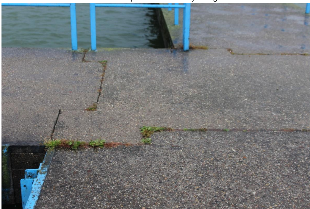
Fot. 70. Nawierzchnia pomostu nr 1.
