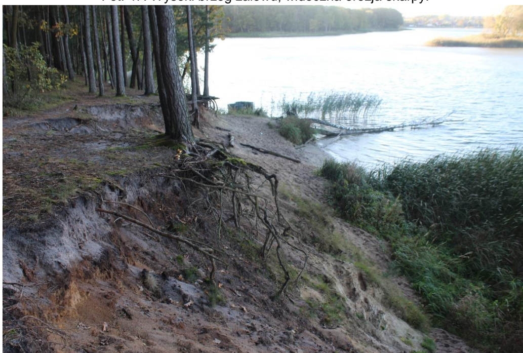
Fot. 48. Wysoki brzeg zalewu, widoczna erozja skarpy.
