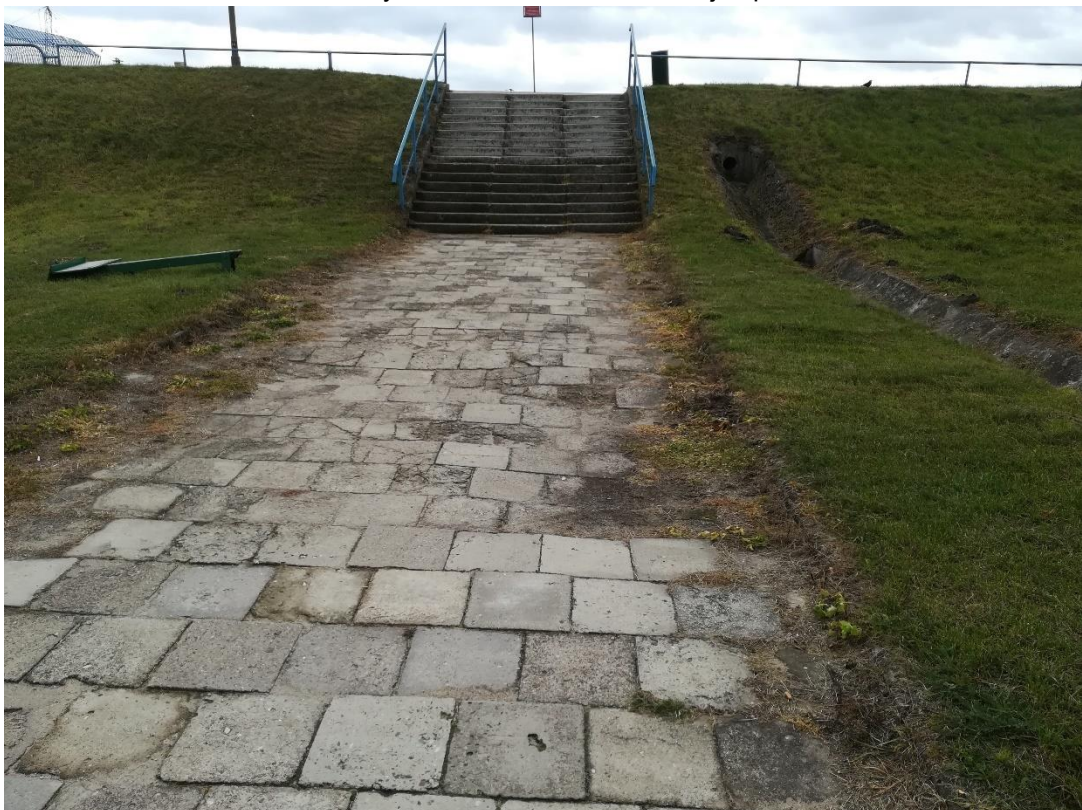
Fot. 14. Widok schodów na skarpie odpowietrznej – lewobrzeżna zapora.
