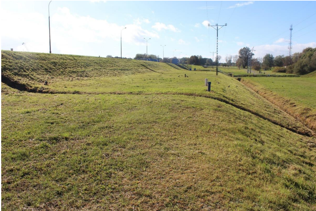
Fot. 9. Widok skarpy odpowietrznej prawobrzeżnej zapory czołowej.
