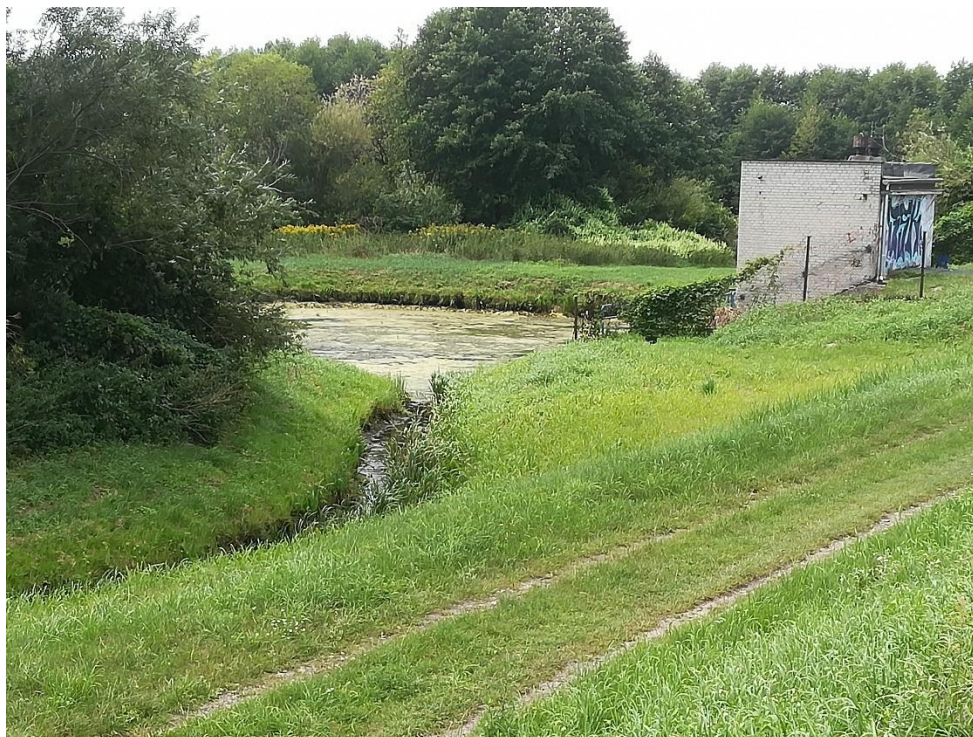
Fot. 79. Widok pompowni P-1 oraz zbiornika retencyjnego – prawy brzeg Zalewu.
