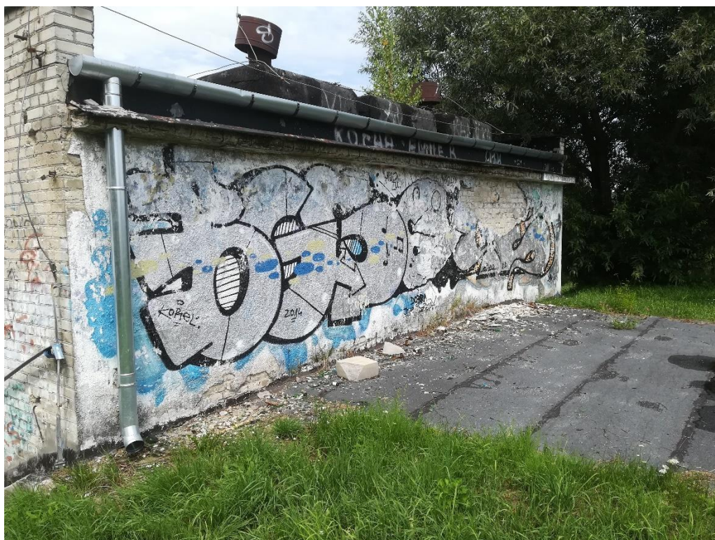
Fot. 85. Budynek pompowni P-2.
