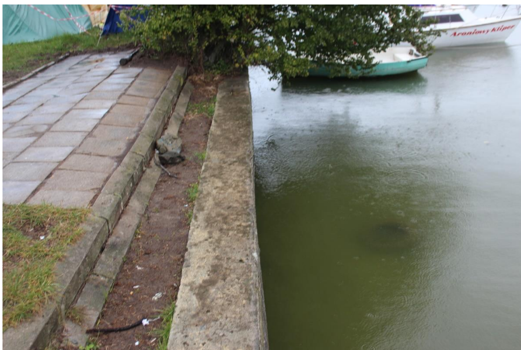
Fot. 63. Końcowy odcinek umocnienia brzegu ścianka szczelną.
