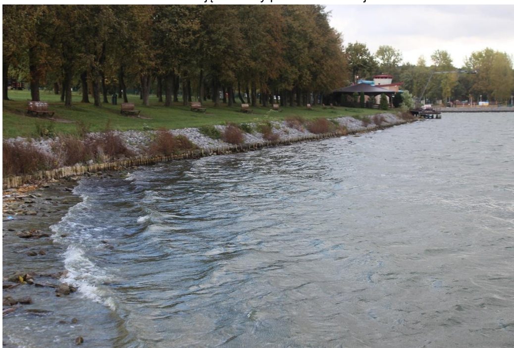
Fot. 32. Ubezpieczenie brzegu materacami gabionowymi w rejonie ujęcia wody.
