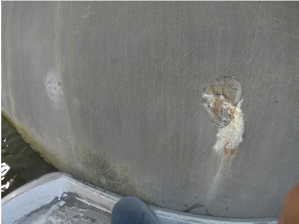
Fot. 27. Powierzchnie betonowe filara środkowego od strony WD.
