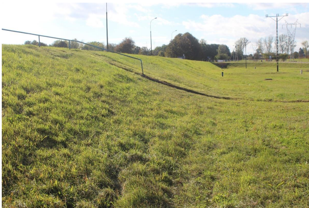
Fot. 11. Widok skarpy odpowietrznej lewobrzeżnej zapory czołowej.
