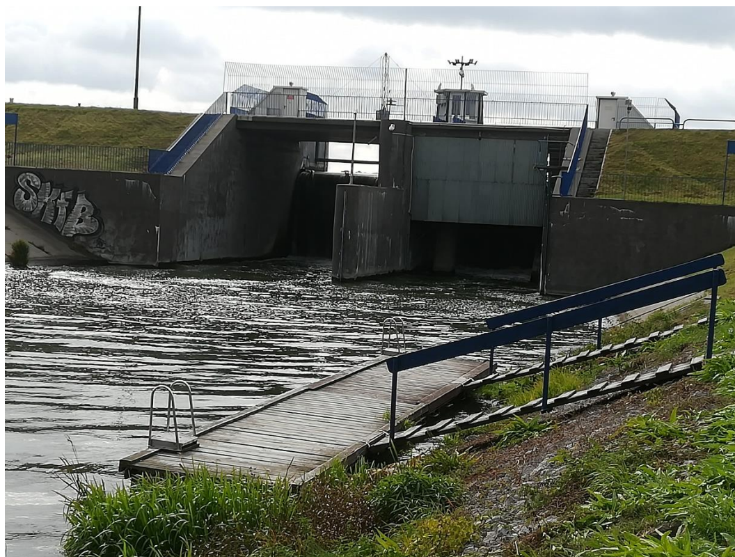
Fot. 15. Widok jazu od strony WD.
