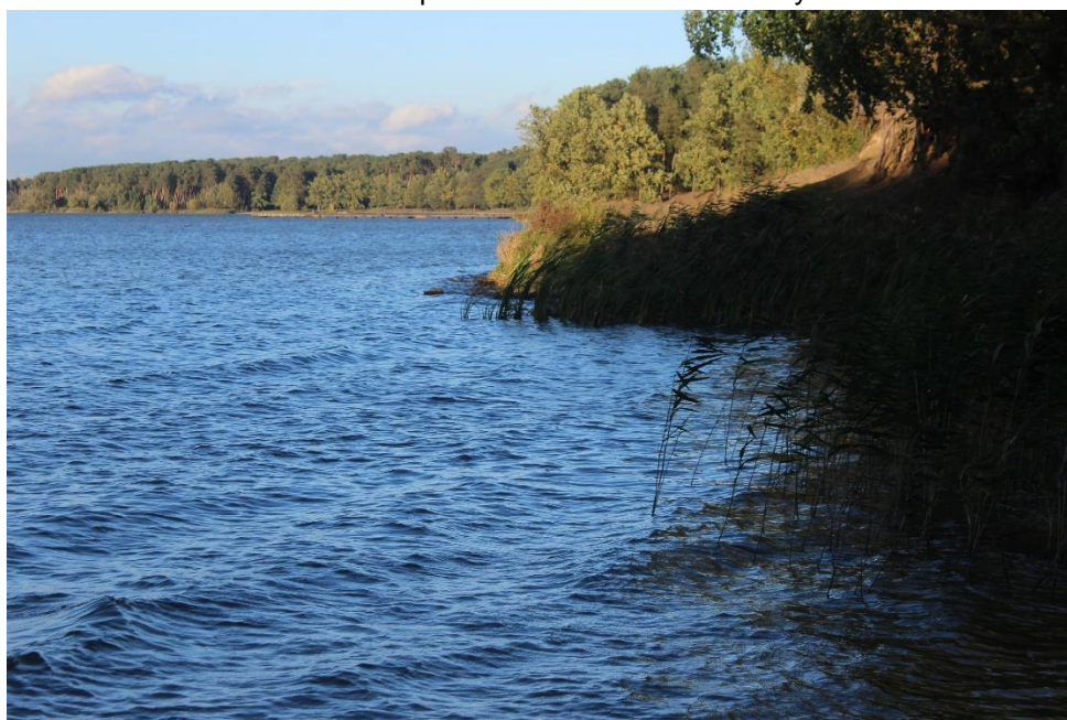
Fot. 46. Koniec ubezpieczenia brzegu narzutem kamiennym.
