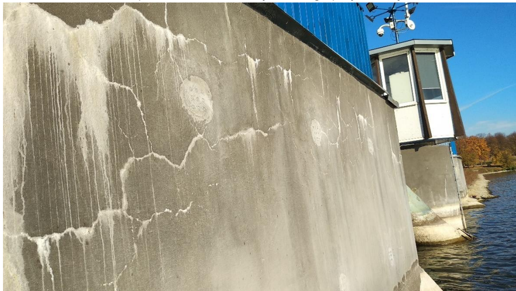
Fot. 18. Widok powierzchni betonowych lewego przyczółka jazu od WG.
