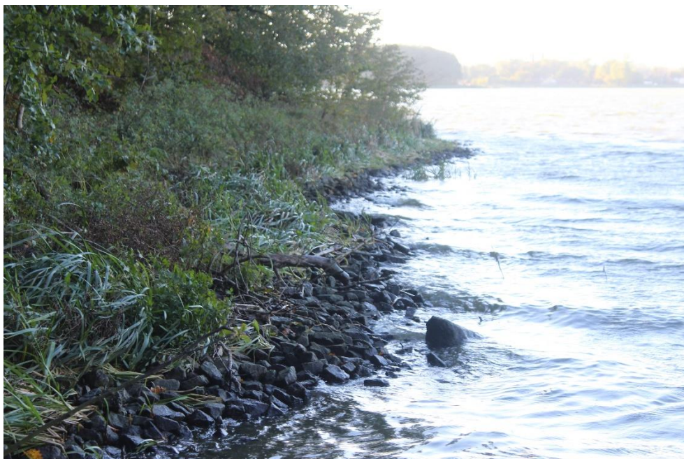
Fot. 45. Ubezpieczenie narzutem kamiennym.
