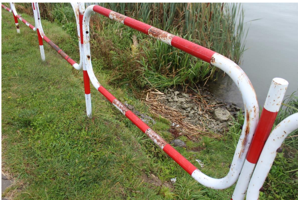
Fot. 65. Umocnienie brzegu narzutem kamiennym.
