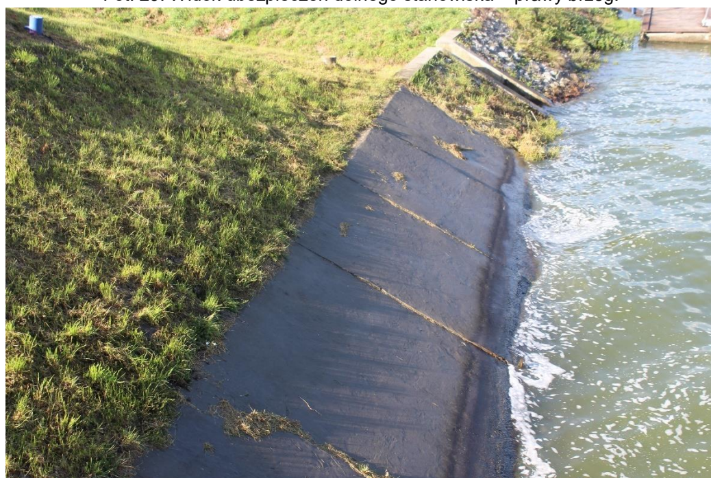
Fot. 30. Widok ubezpieczeń dolnego stanowiska – lewy brzeg.
