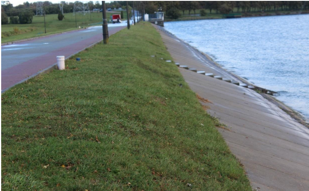
Fot. 1. Widok korony i skarpy odwodnej lewobrzeżnej zapory czołowej
