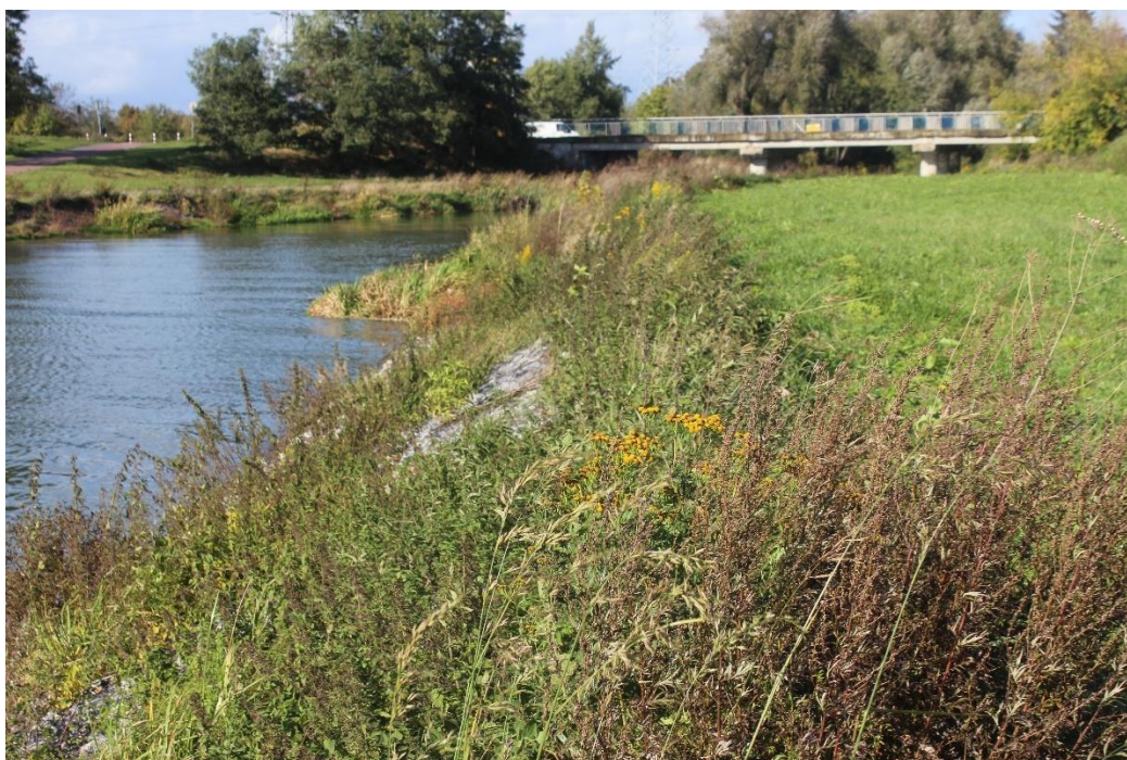
Fot. 29. Widok ubezpieczeń dolnego stanowiska – prawy brzeg.
