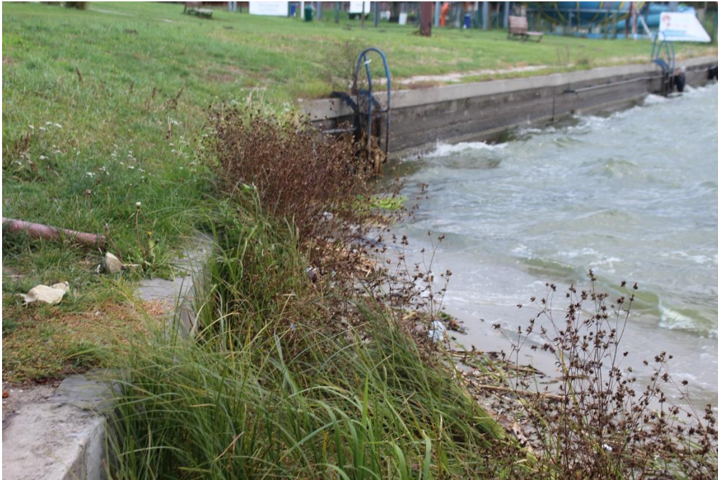
Fot. 33. Początek umocnienia brzegu ścianką szczelną zwieńczoną oczepem żelbetowym.
