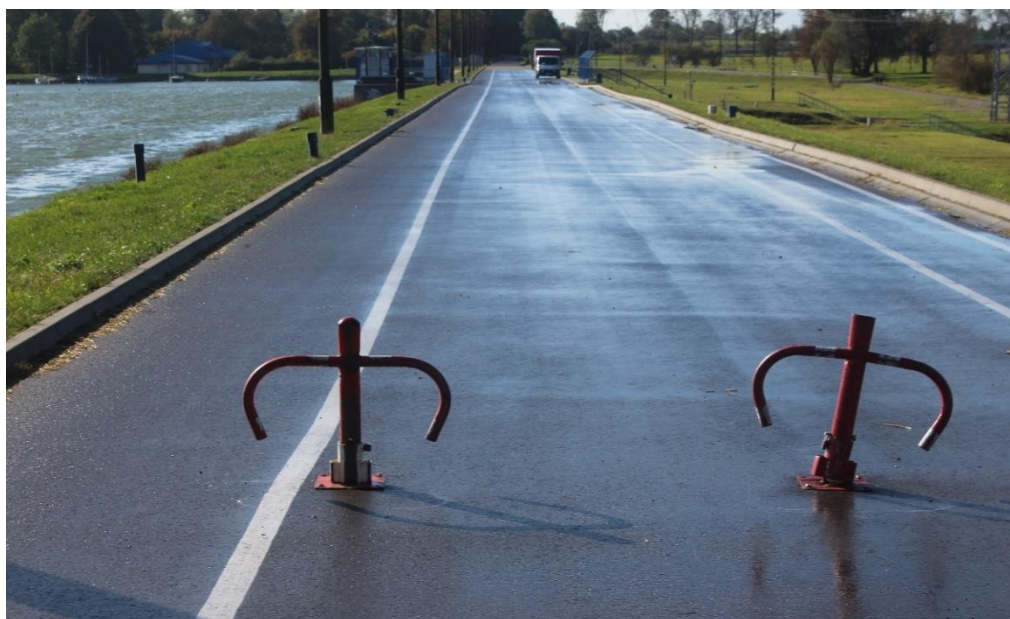
Fot. 3. Korona prawobrzeżnej zapory czołowej.
