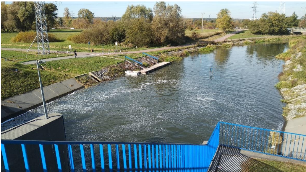
Fot. 28. Widok ubezpieczeń skarp dolnego stanowiska jazu.
