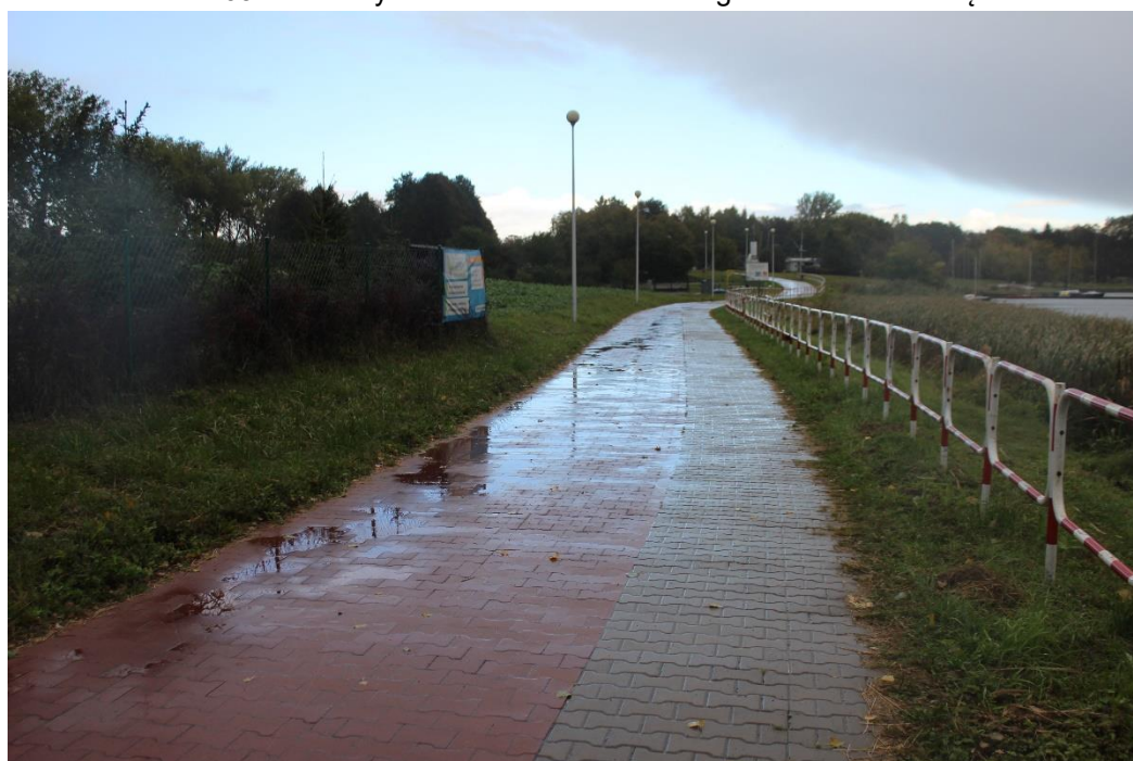
Fot. 64. Widok ścieżki pieszo-rowerowej brzegu z umocnieniem typu biologicznego.
