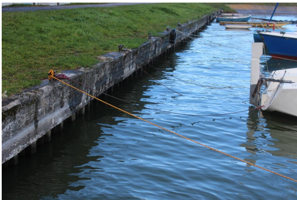
Fot. 55. Widok oczepu żelbetowego nabrzeża pionowego.
