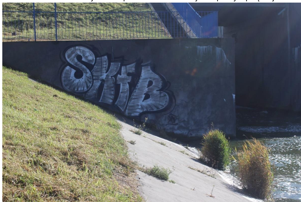
Fot. 22. Widok powierzchni betonowych prawego przyczółka jazu od WD.
